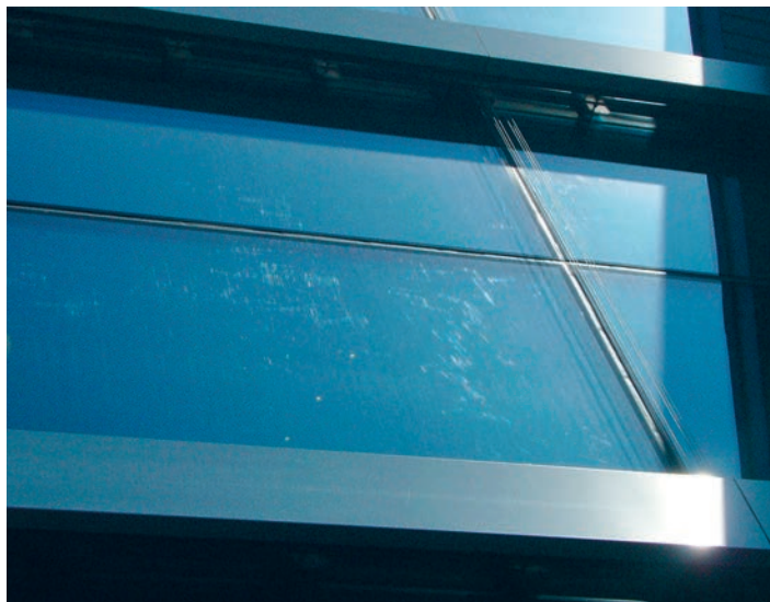
Reinigungskratzer an Einscheiben-Sicherheitsglas (ESG) sind bei Sonnenstrahlung besonders gut sichtbar.
